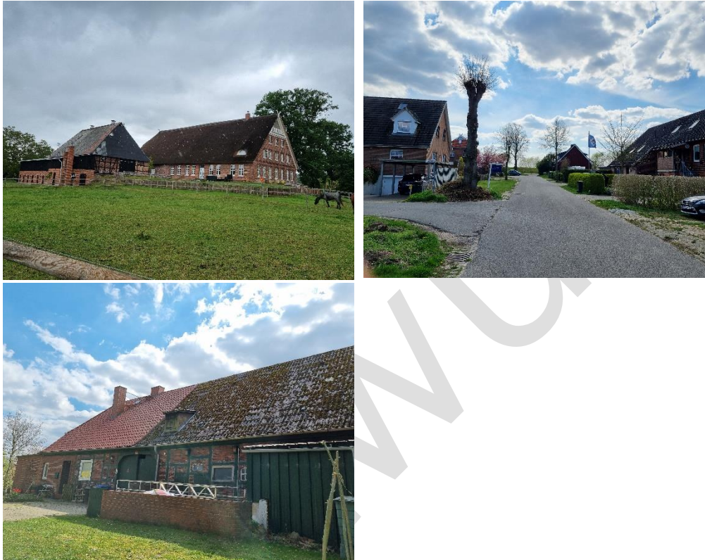
Abbildung 23: Ansichten aus Mover (Quelle: NLG 2025)
