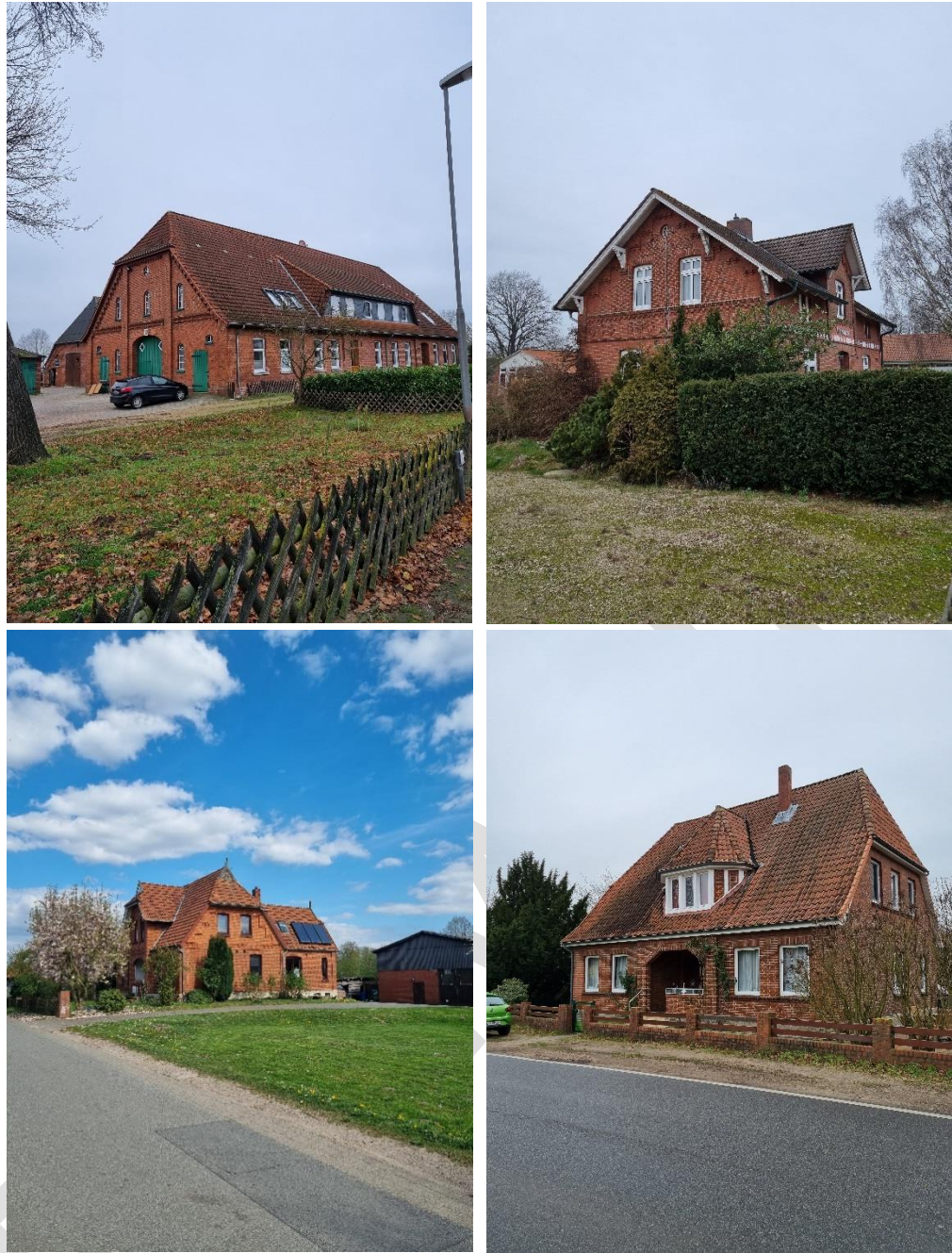
Abbildung 28: Gauben und Dachabschlüsse (Quelle: NLG 2024, 2025)
