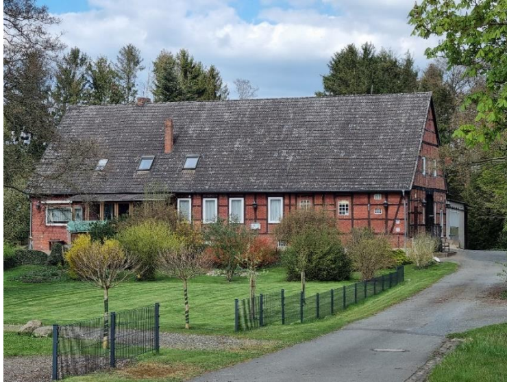
Abbildung 26: Fachwerkhallenhaus mit roten Vollziegeln (Quelle: NLG 2025)
